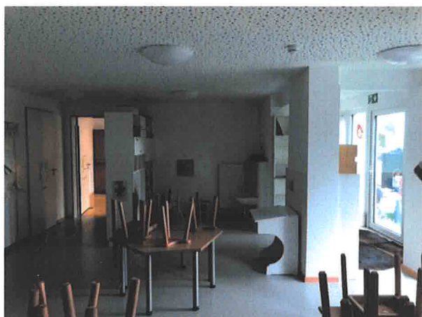
Erweiterung Kindergarten Schneckenhaus
