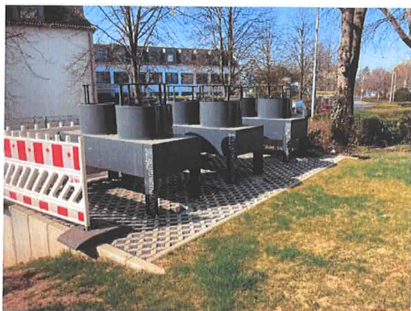
Sanierung Heizungsanlage Wohnpark Nord
