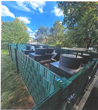
Sanierung Heizungsanlage Wohnpark Nord
