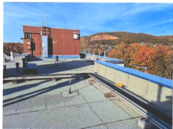
Dachsanierung Wohnpark Nord
