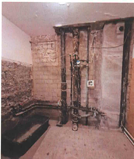
Strangsanierung Wohnpark Nord
