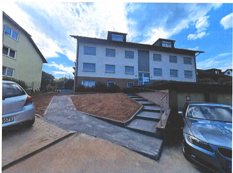
Sanierung Außenanlagen Herresbacher Str. 39
