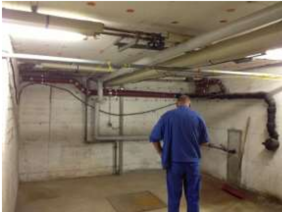
Strangsanierung Wohnpark Nord
